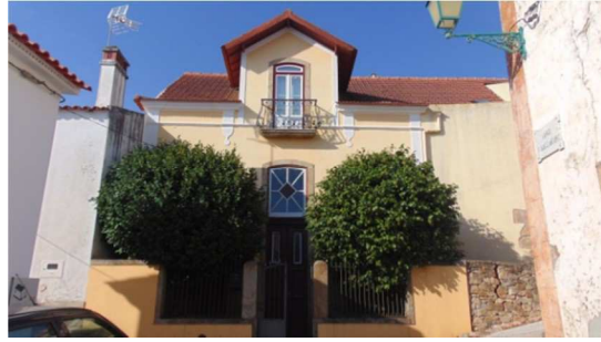
Figura 21: Edifício Razoável/Bom, Largo de St.º António.
