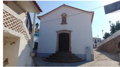
Figura 29: Capela da Misericórdia.
