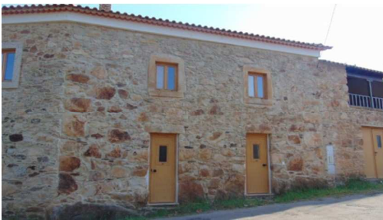
Figura 22: Edifício Reabilitado, rua da Fontainhas.
