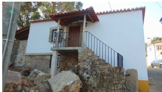
Figura 23: Edifício Reabilitado, rua do Cabril.
