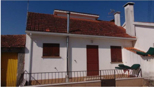
Figura 20: Edifício Dissonante, Largo do Adro.
