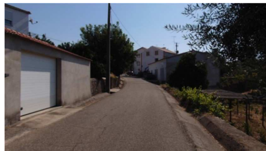
Figura 13: rua Moinho das Freiras.
