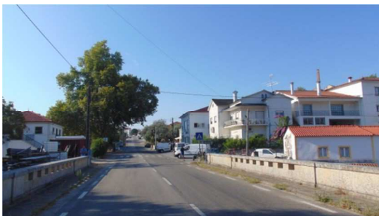
Figura 12: Ponte sobre a Ribeira dos Porteleiros.
