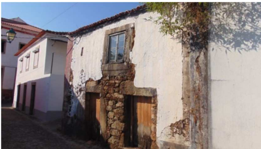
Figura 16: Edifício em Ruína, rua do Cabril.
